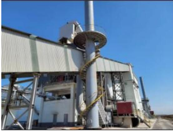
石灰窑原料系统除尘器
