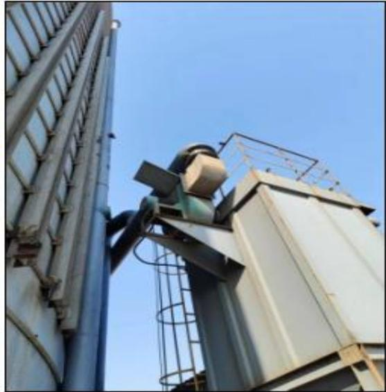
3#仓底落料装车废气除尘器
