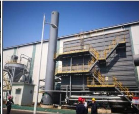
320m<sup>2</sup> 烧结机混合制粒除尘器
