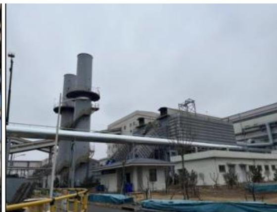
高炉矿（焦）槽废气除尘器
