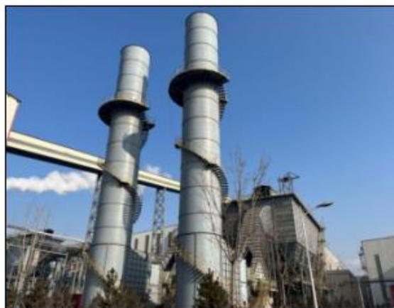
转炉三次废气袋式除尘器
