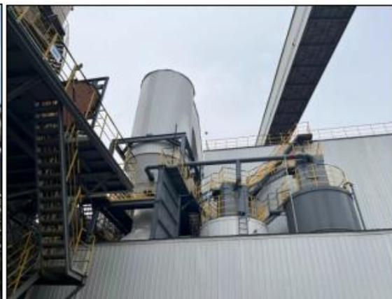
高炉热风炉烟气 ACA 脱硫系统
