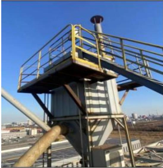
3#仓顶进料废气除尘器
