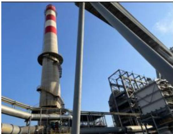
高炉热风炉烟气 SCR 脱硝系统
