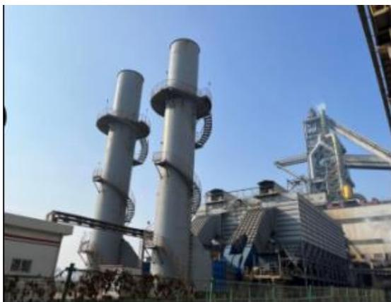
高炉出铁场废气除尘器
