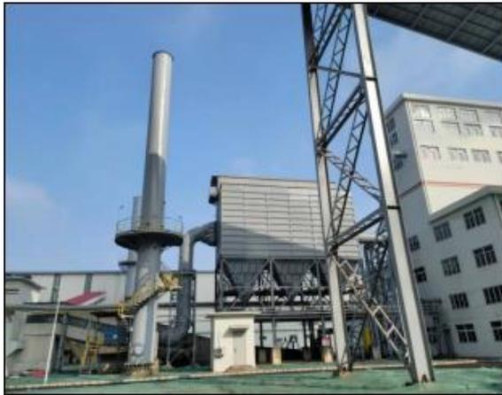
320m<sup>2</sup> 烧结机燃料破碎除尘器
