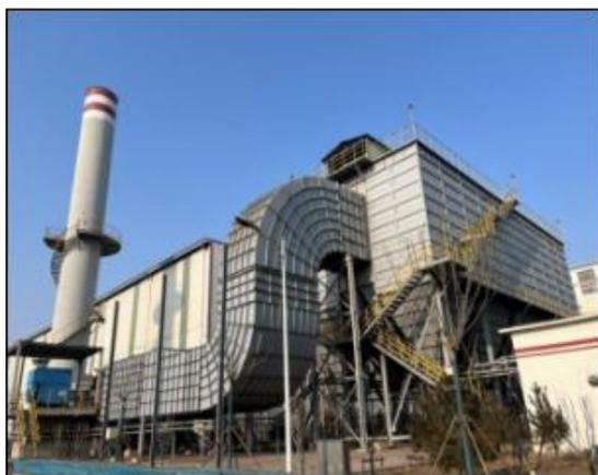
原料场转运 C1 废气袋式除尘器
