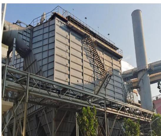
320m<sup>2</sup> 烧结机机尾电袋复合除尘器
