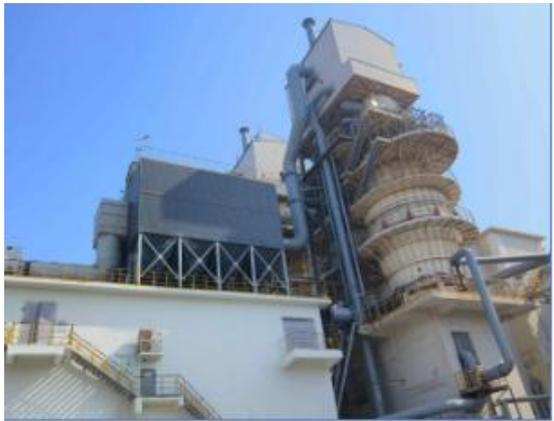
石灰窑焙烧烟气除尘器
